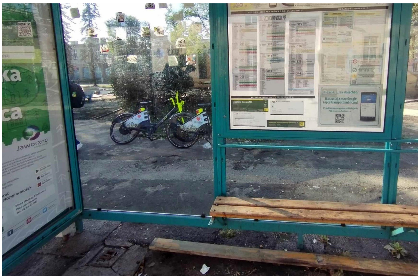
Zdjęcie 13: Jaworzno przystanek Szczakowa Dworzec PKP. Przystanek jest wyposażony w miejsca dla osób na wózkach inwalidzkich, jednak fatalna nawierzchnia uniemożliwia wjechanie na nie.
