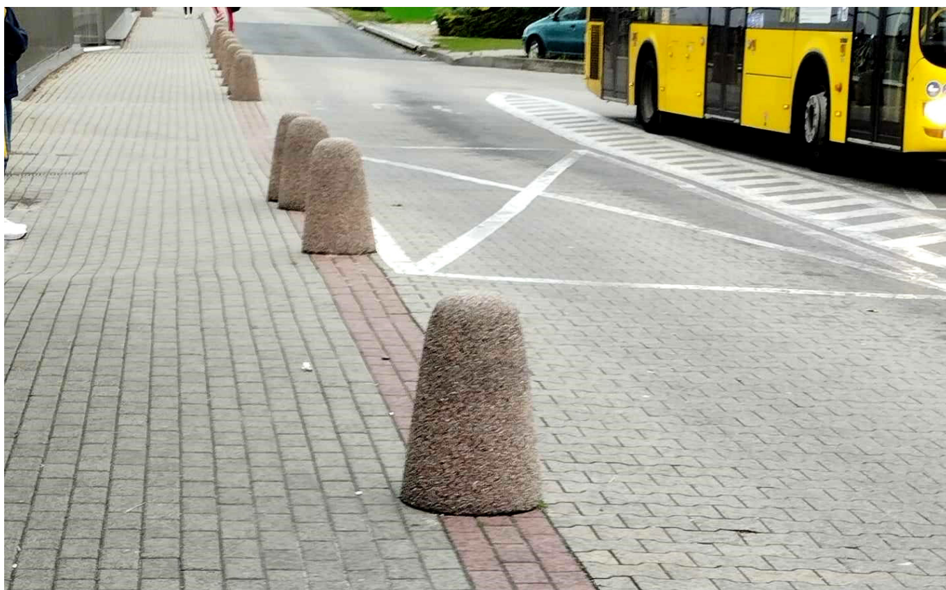
Zdjęcie 19: Linia prowadząca na przystanku Osiedle Paderewskiego Trzy Stawy w Katowicach. Na linii prowadzącej znajdują się betonowe słupy, co jest niebezpieczne dla osób niewidomych.
