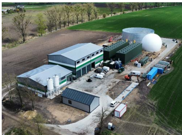
■ Demonstrator technologii – pełnoskalowa instalacja biometanowa
