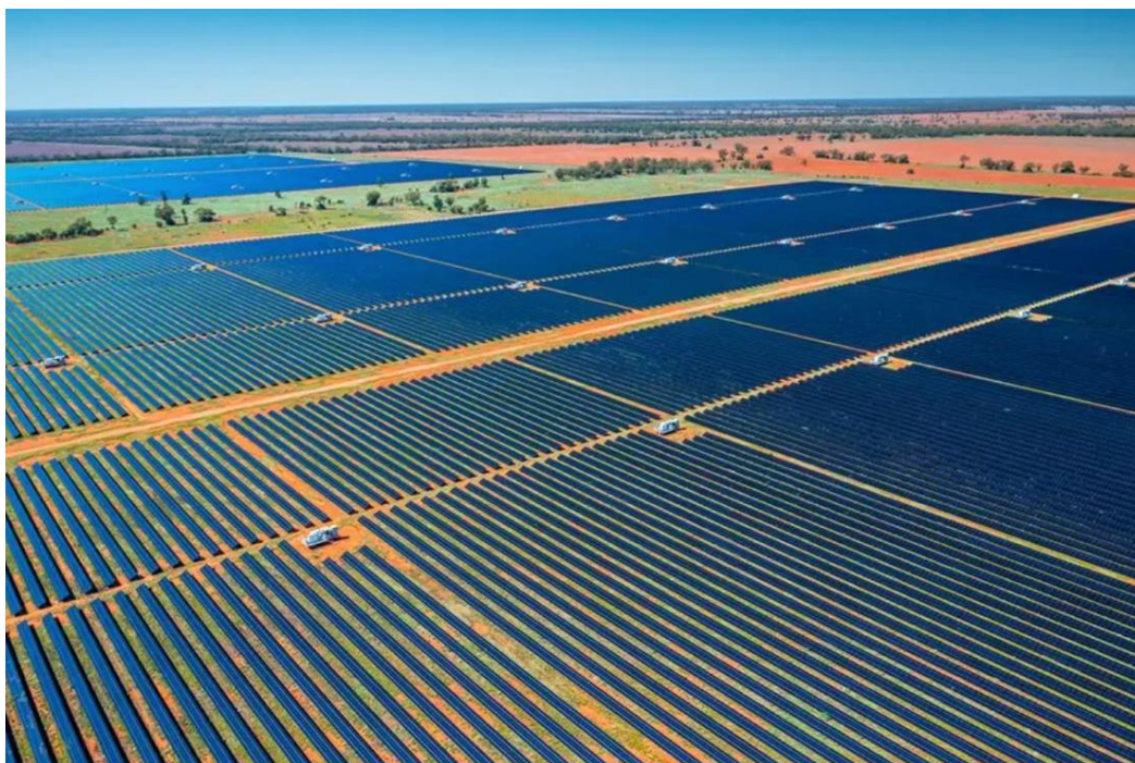
Elektrownia słoneczna Sudair Solar PV
