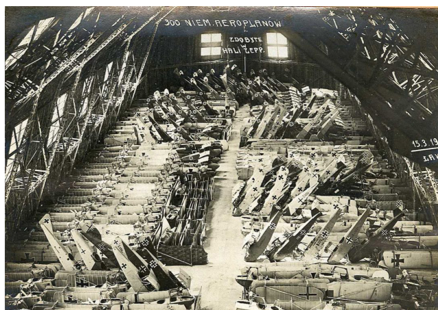
Hala Zeppelinów na Winiarach, zawierająca prawie 400 samolotów w różnym stanie skompletowania. Budynek został zdobyty podczas Bitwy o Ławicę w czasie trwania Powstania Wielkopolskiego. Autor: Nieznany, zbiory Biblioteki Narodowej sygnatur aAFF.III-79 (Zawiera F.53705-53747).
